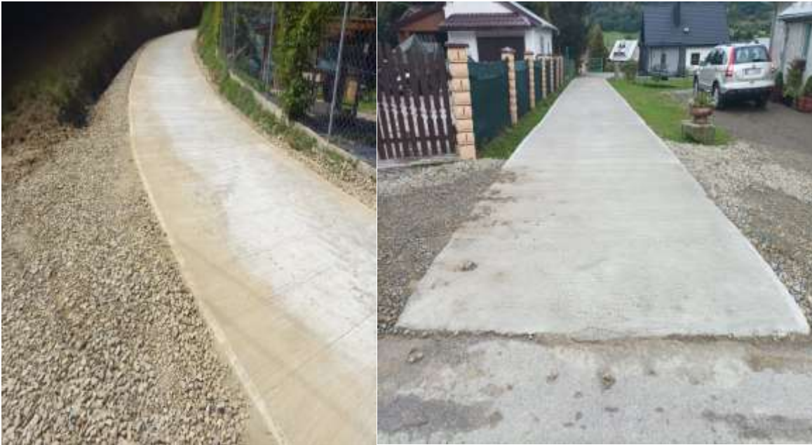
Remont drogi Niwa-Gronie i Pustki w Kamienicy Dolnej. Wartość 48 666,42 zł
