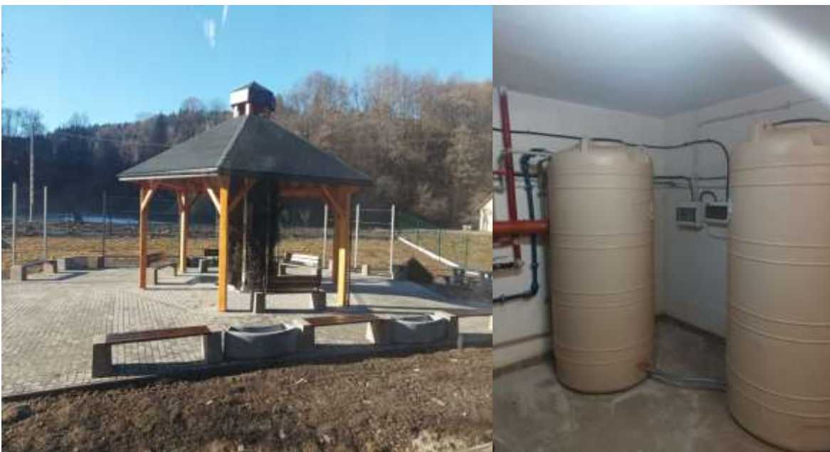
Budowa tężni solankowej Wartość inwestycji 420 860,91 zł
