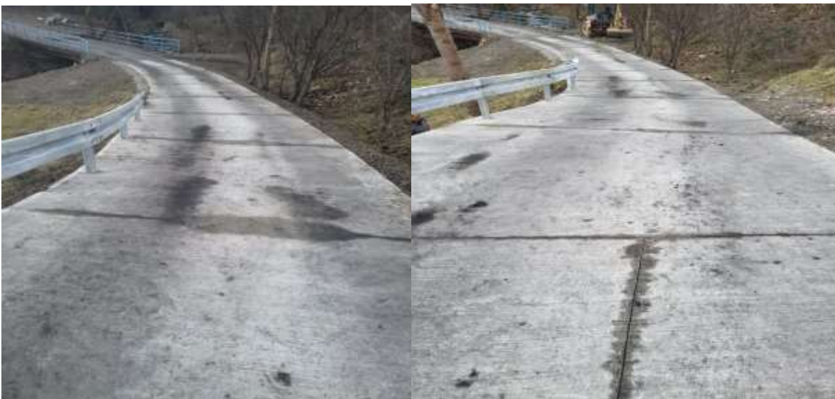
Remont drogi Zasadnioki w Zasadnem Wartość 36 097,74 zł
