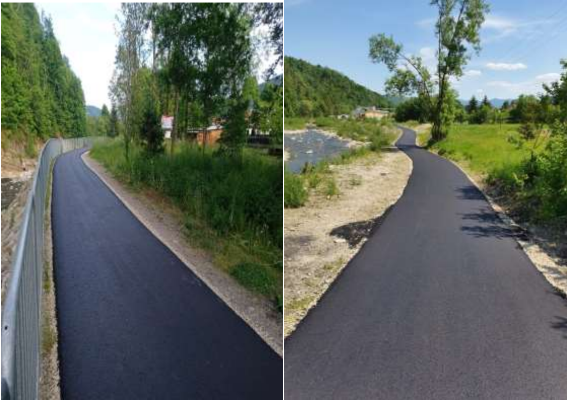
Modernizacja ścieżki rowerowej wartość 232 607,45 zł
