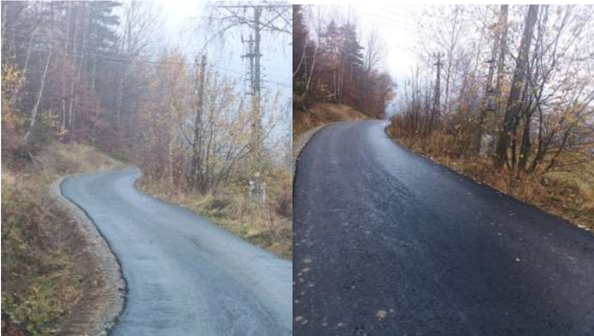
Modernizacja drogi Faltynówka, długość 2 200 m, Wartość 1 116 431,93 zł
