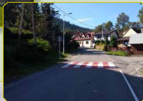
Modernizacja drogi Kamienica – Zasadne
