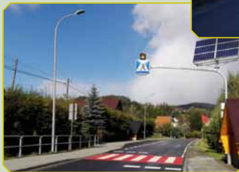
Modernizacja drogi powiatowej w Zalesiu z budową parkingów, chodników i oświetlenia
