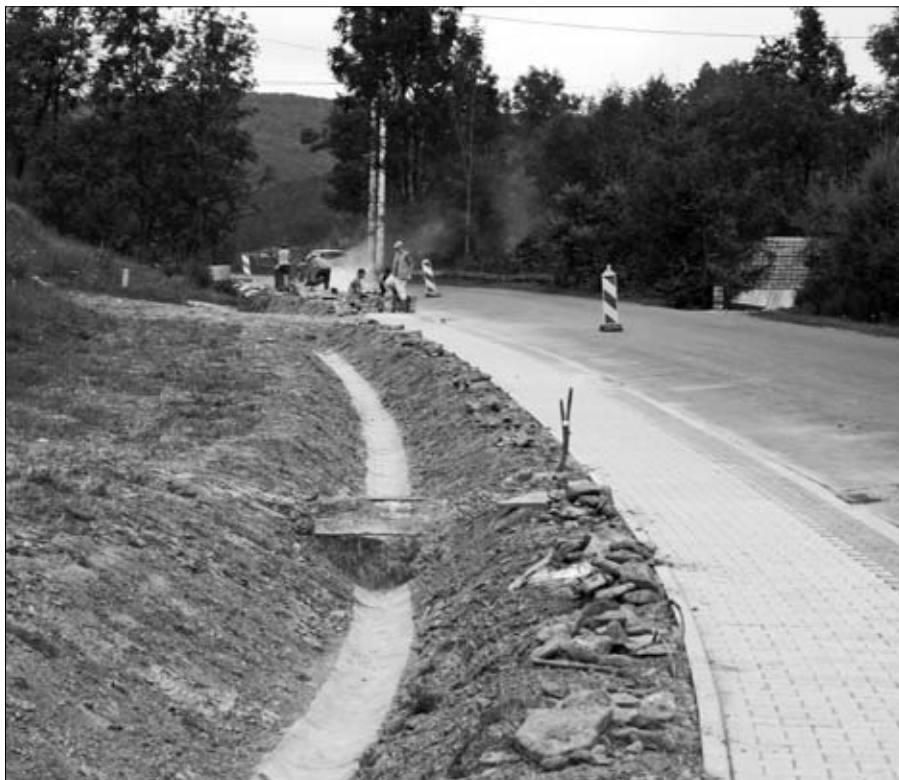
Budowa chodnika w Zbludzy
