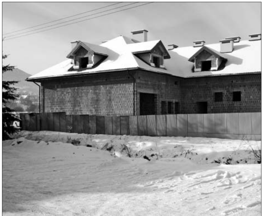
Rozbudowa Ośrodka Zdrowia w Kamienicy
