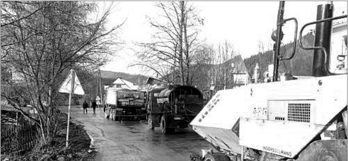
Modernizacja drogi Kuźle – Wąchaty w Szczawie
